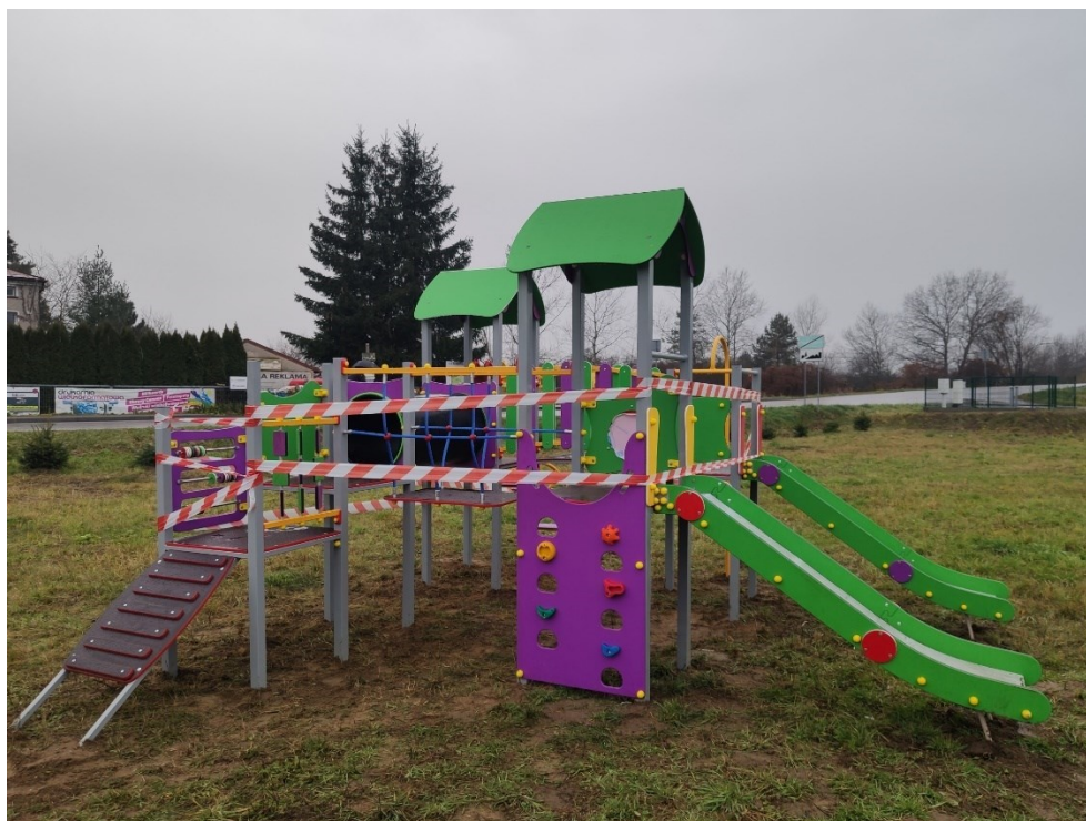
budowa placu zabaw
