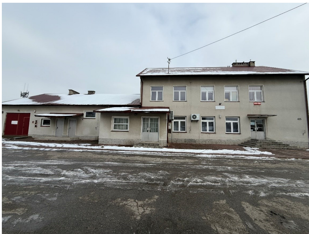
Budynek komunalny ze świetlicą wiejską oraz zapleczem od strony frontowej
